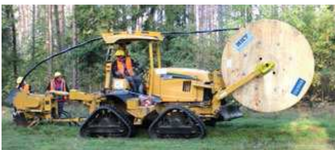
Rys. 4. Pługoukładacz wibracyjny z wysięgnikiem na bęben kablowy z kablem trzyżyłowym AXAL-TT-PRO
